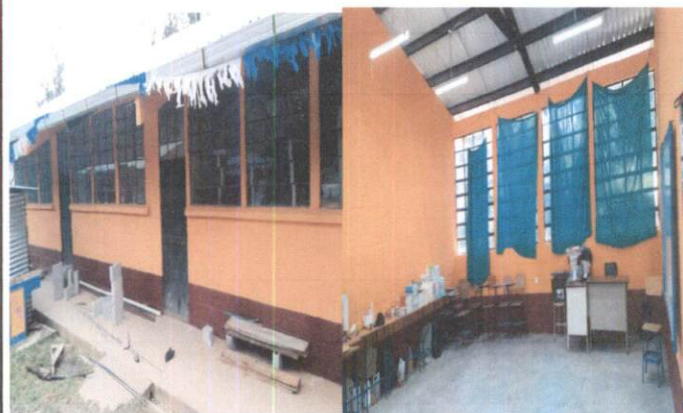
Foto 4: Se finalizó la pintada de las paredes interior y exterior del instituto.
