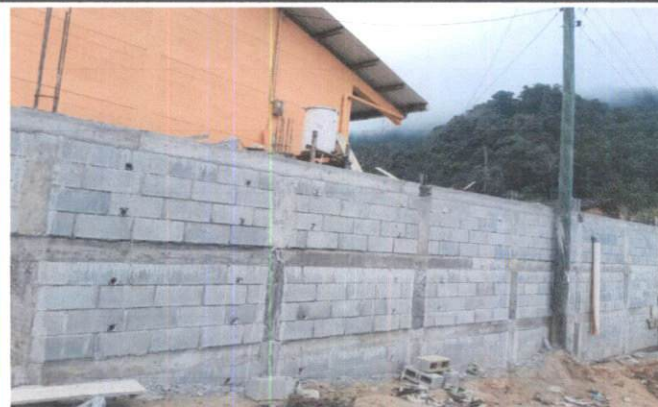
Foto 2: Se finalizó el muro perimetral del instituto.
