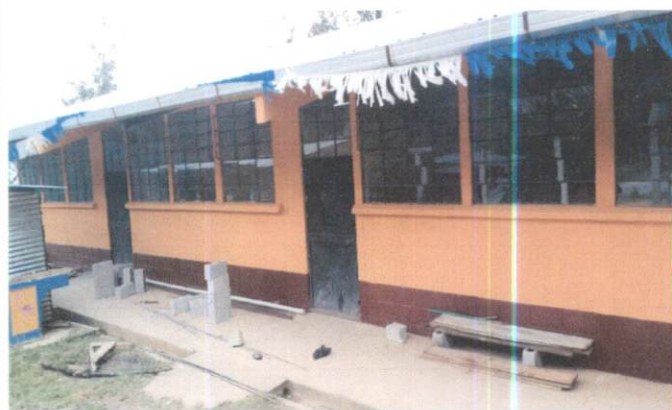
Foto 1: Se finalizó la pintada de las paredes del instituto.
